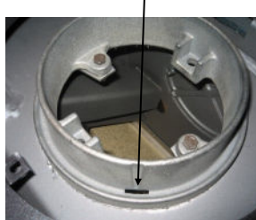
Kondenssin poistoaukko on valmis.
