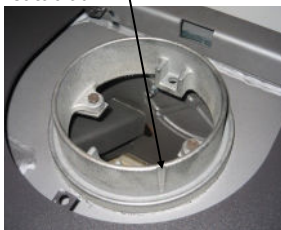
Markierung für den Kondensatablauf.
